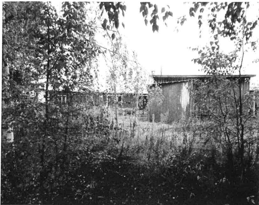
Vanhan rakennuksen kylkeen rakennettu suoja. Liite 1
